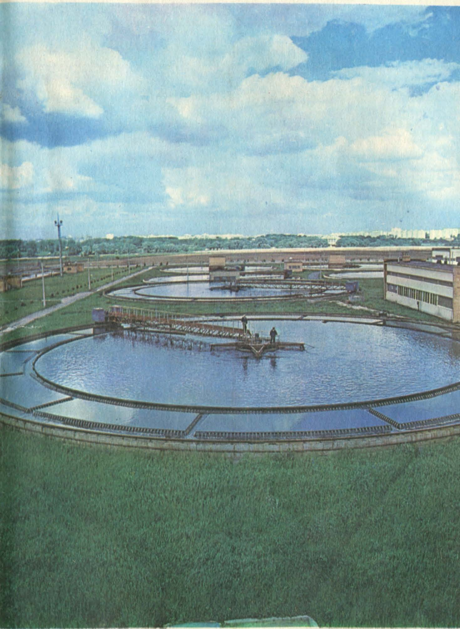
Объединение Курьяновских станций аэрации — крупнейшие очистные сооружения нашей страны. На снимке вы видите аэротенки-водоемы, в которых сточные воды проходят биологическую очистку.
